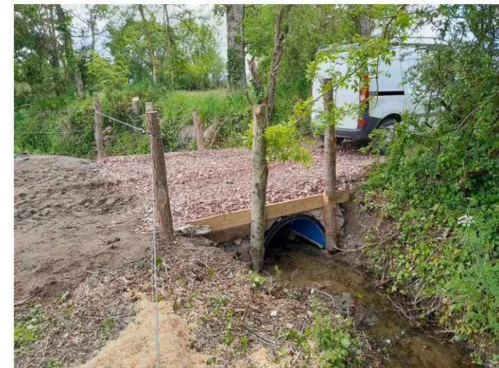
Modification d'ouvrage par hydrotube sur Le ruisseau du Bouillon
