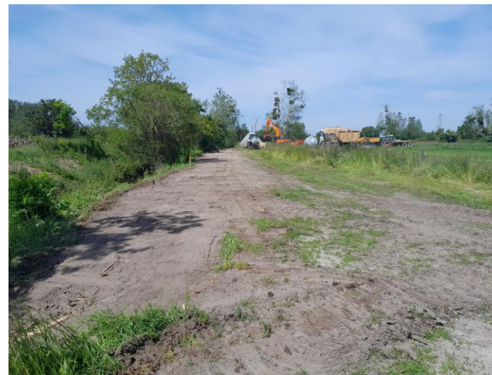
Suppression de merlon de curage sur Le Passevin
