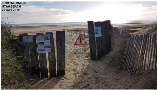
Sécurisation au niveau d'un accès à la zone de chantier © DDTM 50
