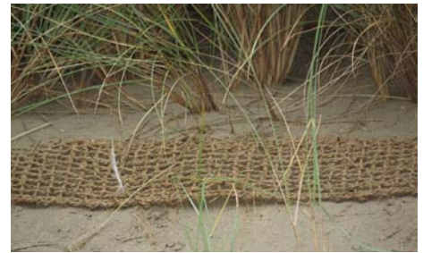
Filet anti-érosion en en fibres de coco et plantation d'oyats - © Cerema
