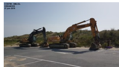
Stationnement des engins de chantier © DDTM 50
