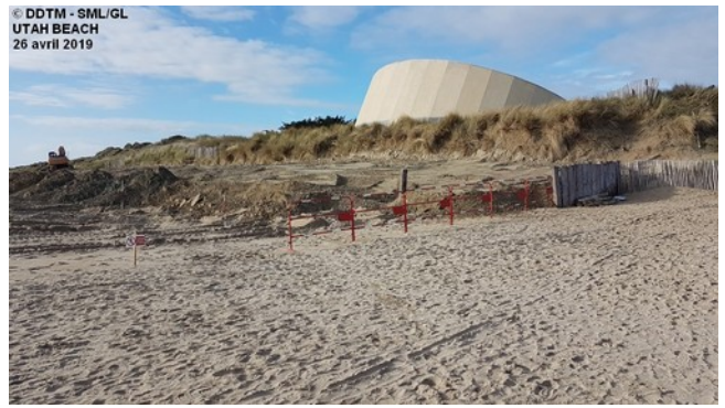
Sécurisation au niveau d'une zone de rechargement devant le musée du débarquement à Utah Beach - © DDTM 50
