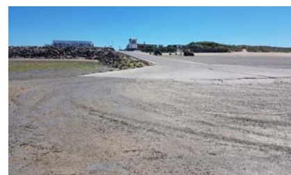
Cale du Grand Herbet : les cales perpendiculaires au trait de côte jouent le rôle d'épis et participent à l'érosion différentielle de la plage (érosion en aval de la cale et accrétion en amont) © DDTM50
