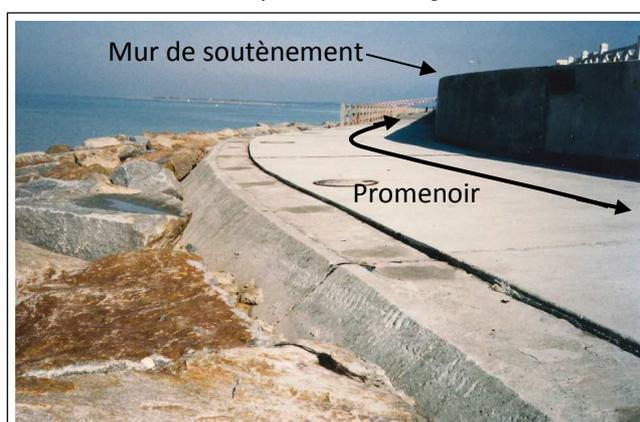
Figure 3 : Photo de la remise en état du promenoir et du mur de soutènement (1988)
